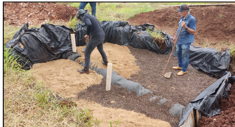
Figura 4: Construção da BET no município de Doutor Camargo
